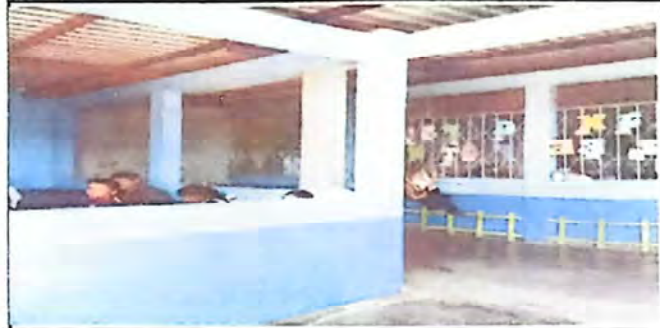
Foto 4: Suministro y sustitucion de balcones de metal
