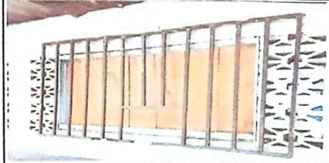
Foto 2: Suministro y sustitucion de balcones de metal
