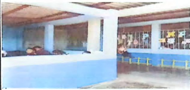
Foto 1: Suministro y reparación de muro de block
