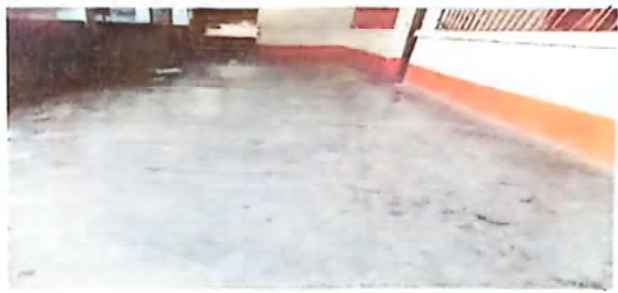
Foto 3: Sustitución de piso de torta de cemento por piso cerámico
