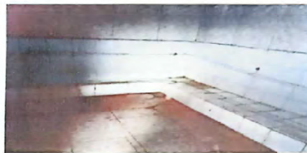
Foto 4: Suministro y sustitución de azulejos para migitorios
