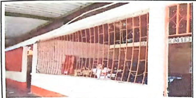
Foto 3: Suministro y sustitucion de balcones de metal
