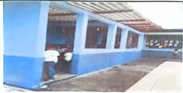
Foto 2: Sustitución de puerta metálica
