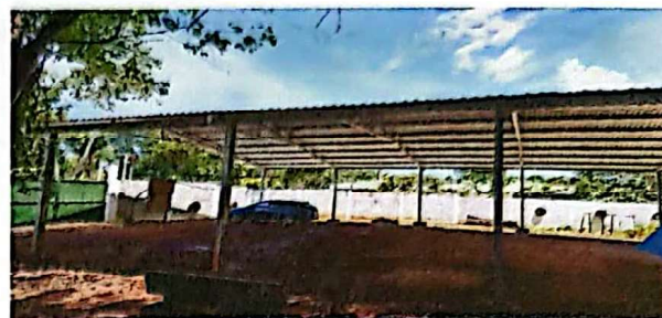
Foto 2: INSTALACIÓN DE ESTRUCTURA METÁLICA
