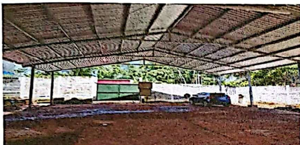
Foto 3: INSTALACIÓN CUBIERTA DE LÁMINA TROQUELADA
