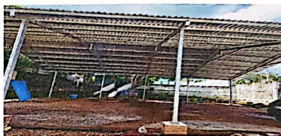
Foto 4: INSTALACIÓN CUBIERTA DE LÁMINA TROQUELADA
