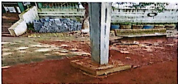
Foto 1: INSTALACIÓN DE ESTRUCTURA METÁLICA
