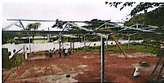
Foto 2: INTALACIÓN DE ESTRUCTURA METÁLICA
