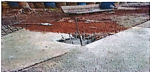
Foto 1: INSTALACIÓN DE ESTRUCTURA METÁLICA
