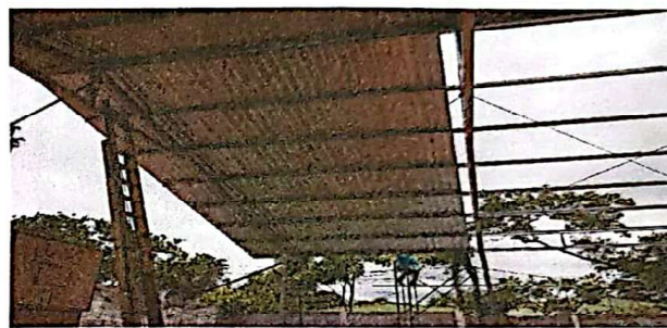
Foto 4: INSTALACIÓN CUBIERTA DE LÁMINA TROQUELADA
