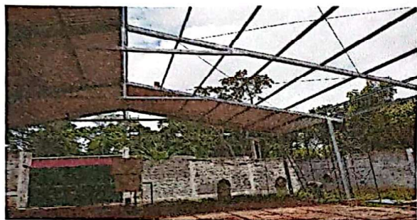
Foto 3: INSTALACIÓN CUBIERTA DE LÁMINA TROQUELADA
