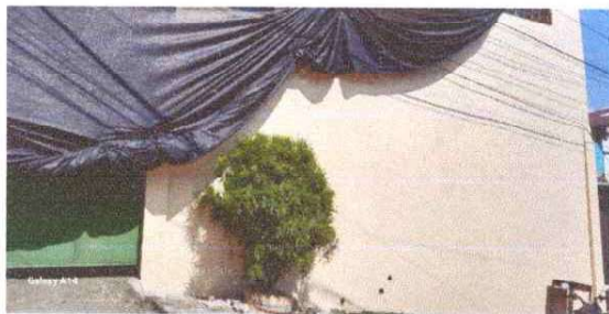
Foto 3: REPARACIÓN DE REPELLO EN MURO DE CONCRETO Y PINTURA DE PARED
