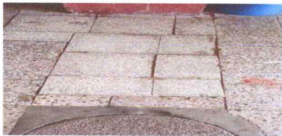
Foto 5: REPARACIÓN DE DRENAJE POR HUNDIMIENTO EN PASILLO
