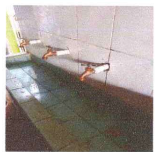
Foto 4: SUSTITUCION DE SANITARIOS Y SUSTITUCION DE GRIFOS
