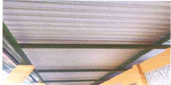
Foto 2: MANTENIMIENTO DE ESTRUCTURA METÁLICA
