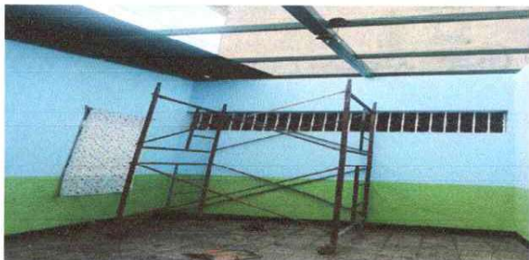
Foto 1: SUSTITUCIÓN DE COBERTURA DE LAMINA ACANALADA POR LAMINA TROQUELADA
