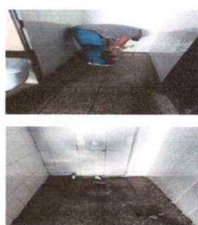
Foto 4: SUSTITUCION DE SANITARIOS Y SUSTITUCION DE GRIFOS
