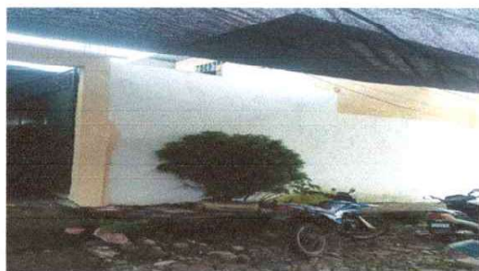
Foto 3: REPARACIÓN DE REPELLO EN MURO DE CONCRETO Y PINTURA DE PARED
