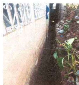
Foto 6: REPARACION DE REPELLO EN MURO DE BLOCK Y SUSTITUCION DE CEDAZO EN VENTANAS DE AULA
