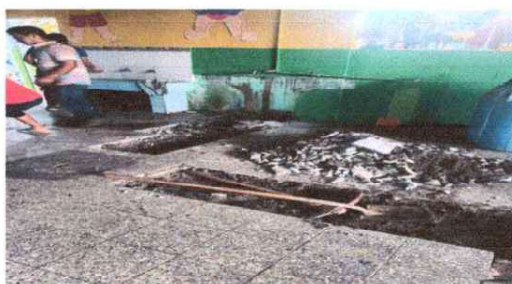
Foto 5: REPARACIÓN DE DRENAJE POR HUNDIMIENTO EN PASILLO
