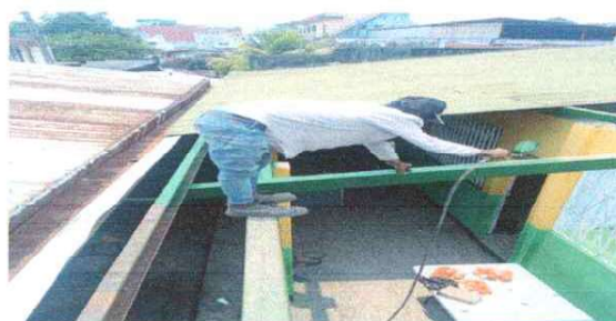
Foto 2: MANTENIMIENTO DE ESTRUCTURA METÁLICA
