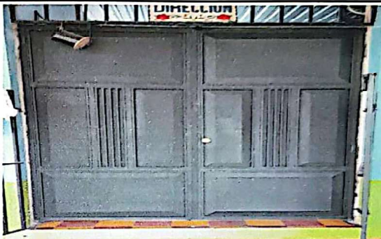
SUSTITUCIÓN DE PUERTA DE METAL.
