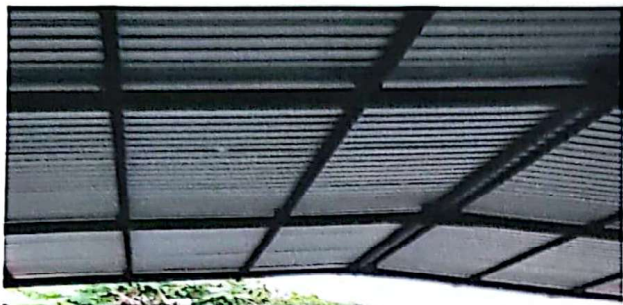
SUMINISTRO E INSTALACION DE ESTRUCTURA METALICA PARA CUBIERTA DE LAMINA
