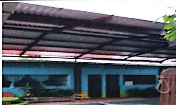
INSTALACION DE TECHO O CUBIERTA DE LAMINA CROCELADA LAMINA ALUZINC C26
