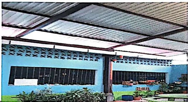
SUSTITUCIÓN DE CANAL DE METAL 40.15 METROS CUADRADOS
