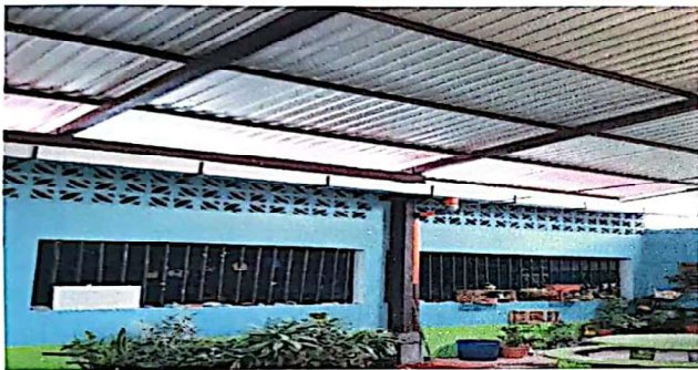
SUSTITUCION DE CANAL DE METAL 40.15 METROS CUADRADOS
