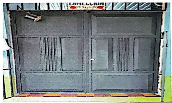
SUSTITUCIÓN DE PUERTA DE METAL
