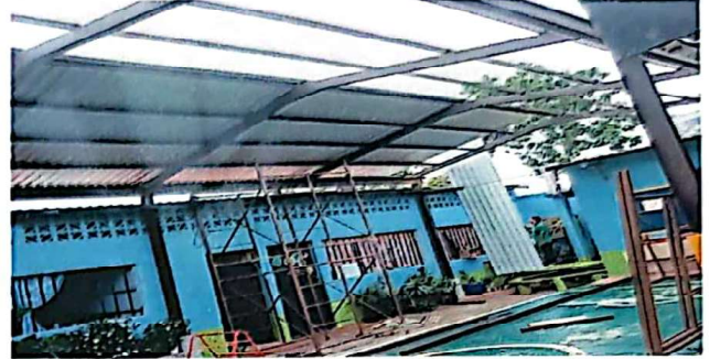
SUMINISTRO E INSTALACION DE TECHO O CUBIERTA DE LAMINA TROQUELADA ALUZINC C26
