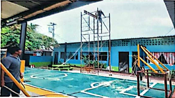
SUMINISTRO E INSTALACION DE ESTRUCTURA METALICA PARA CUBIERTA DE LAMINA
