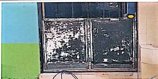
MANTENIMIENTO ESTRUCTURA PUERTA DE BAÑO
