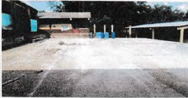
Foto 1: Suministro de cimentacion para techo de patio
