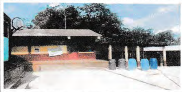
Foto 2: Suministro de Estructura de metálica de patio
