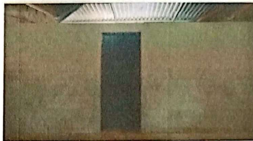
Foto 2: Sustitución de paredes, bodega de almacenamiento 28.08 m2.
