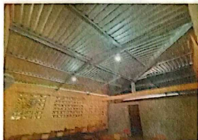
Foto 1: Sustitución de estructura de madera por metal y de cubierta de lámina por lámina troquelada C26, Aula 1 y 2.
