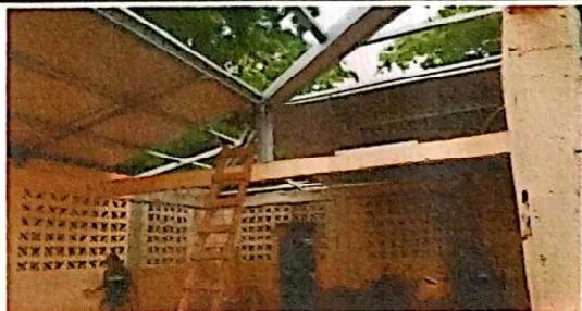
Foto 1: Sustrucción de estructura de madera por metal y cubierta de lámina por lámina troquelada C26, Aula 1 y 2.
