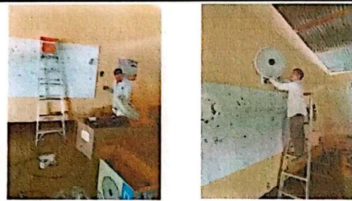
Foto 6: Sustrucción de ventiladores de 6 aulas.
