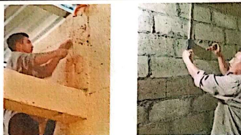
Foto 4: Reparación del sistema eléctrico, aula 1 y 2.
