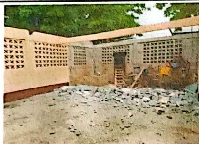
Foto 2: Sustrucción de paredes, bodega de almacenamiento 28.08 m2.
