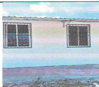
Foto 6: Suministro e instalación de ventanas de pvc
