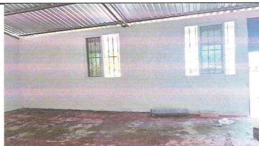
Foto 4: Suministro e Instalacion de Piso de concreto
