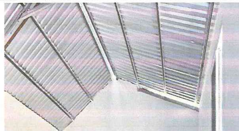
Foto 2: Suministro e instalación de lamina
