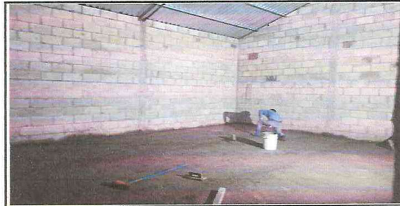
Foto 4: Suministro e Instalacion de Piso
