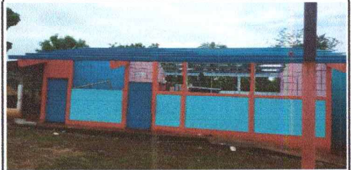
Foto 2: Mantenimiento y reparación de estructura metálica con pintura anticorrosiva.
