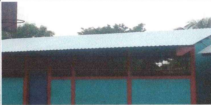
Foto 1: Sustrucción de lámina acanalada por aluzinc troquelada C 26
