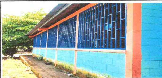
Foto 5: Sustrucción de ventanas de vidrio por hierro módulo 1 y 2
