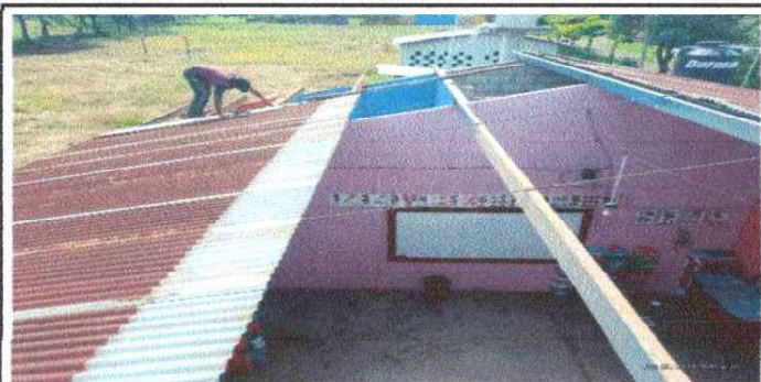
Foto 1: Sustitución de lámina acanalada por aluzinc troquelada C 26
