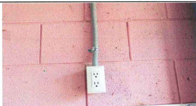
Foto 3: Reparación de sistema eléctrico módulo 1 y 2
