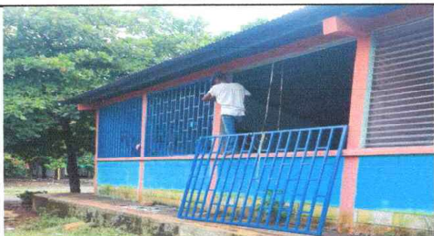
Foto 5: Sustitución de ventanas de vidrio por hierro módulo 1 y 2
