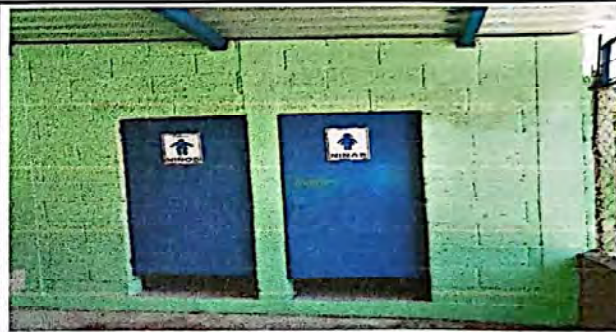
Foto 4: Sustrucción de puertas de metal.
