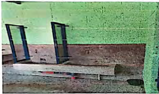
Foto 9: Suministro e instalación de mingitorios de concreto
