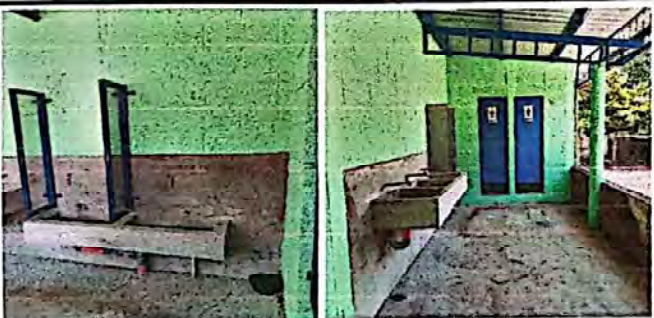
Foto 5: Suministro e instalación de lavamanos de concreto
