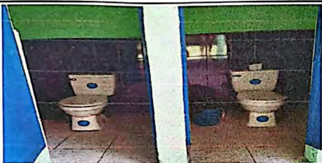
Foto 3: Mantenimiento de servicios sanitarios
