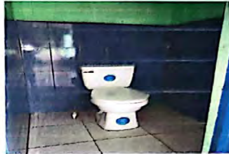
Foto 8: Sustrucción de azulejo en paredes de SANITARIOS.
