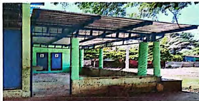
Foto 2: Sustrucción de cubierta de lámina troquelada calibre 26, en servicios sanitarios
