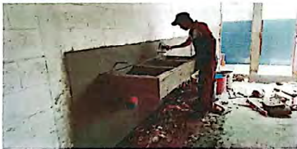
Suministro e instalación de lavamanos de concreto
