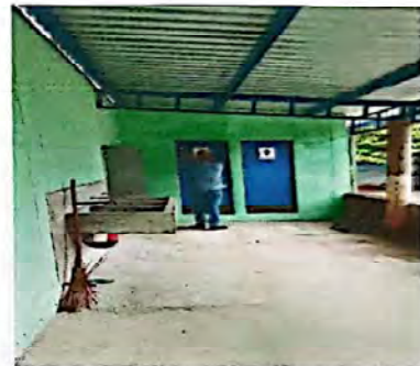
Sustitución de puertas de metal
