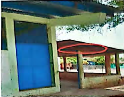
Sustitución de cubierta de lámina troquelada calibre 26, en servicios sanitarios
