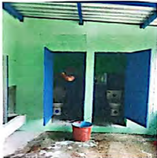
Mantenimiento de servicios sanitarios
