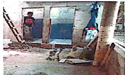
Sustitución de puertas de metal
