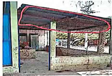
Sustitución de cubierta de lámina troquelada calibre 26, en servicios sanitarios
