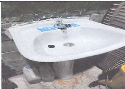
Foto 1: Suministro e instalación de lavamanos, baño de maestros.
