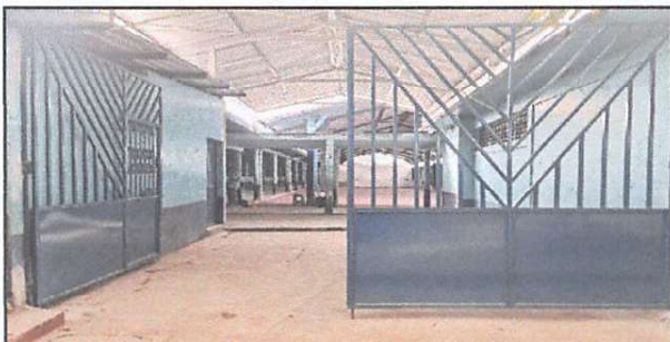
Foto 7: Suministro y reparación de portón de entrada.
