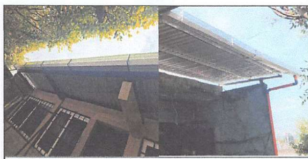
Foto 5: Suministro e instalación de canales.
