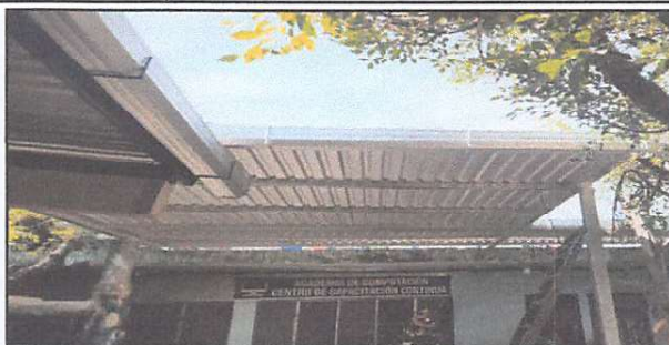
Foto 2: Suministro e instalación de lámina troquelada calibre 26, en el modulo de computación.
