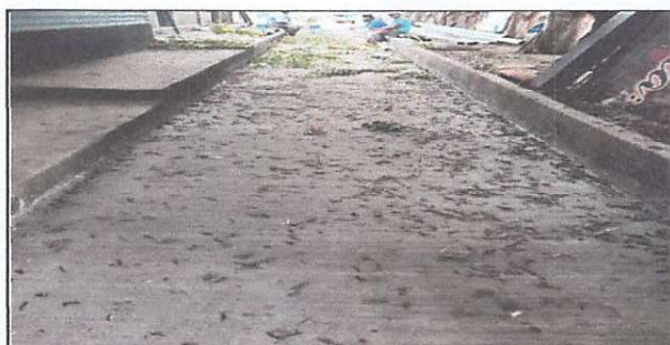
Foto 4: Suministro y sustitución de la torta de concreto, modulo de computación.
