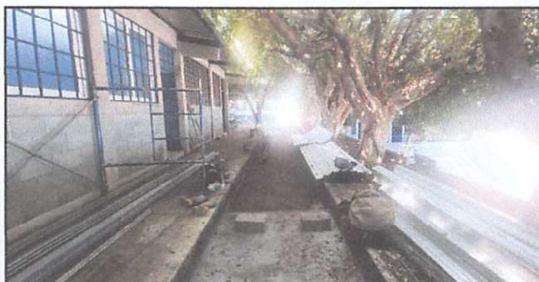
Foto 4: Suministro y sustitución de la torta de concreto, módulo de computación.
