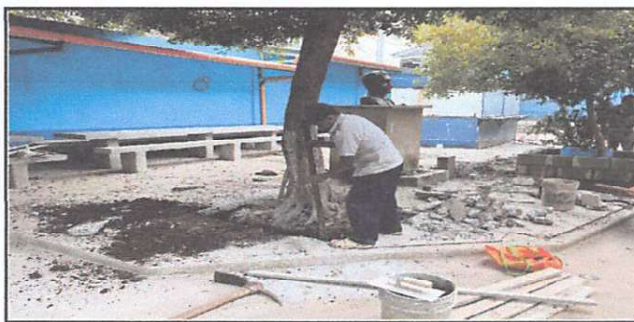
Foto 9: Suministro y reparación de jardines.
