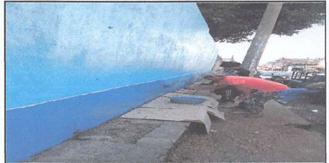
Foto 2: Suministro y aplicación de pintura exterior.
