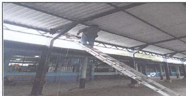
Foto 3: Suministro e instalación de sistema eléctrico, patio interno.
