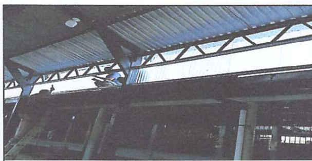
Foto 6: Suministro e instalación de lámina transparente en el patio interno.
