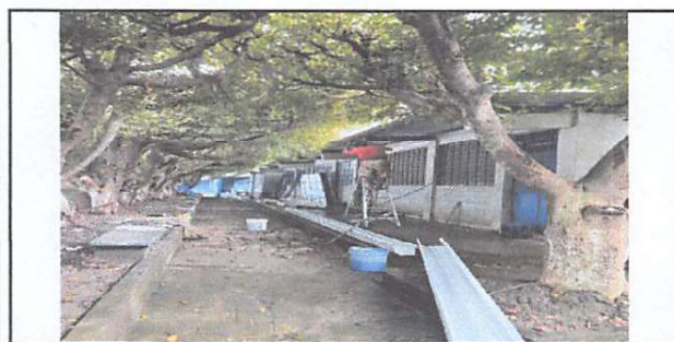
Foto 5: Suministro e instalación de canales.
