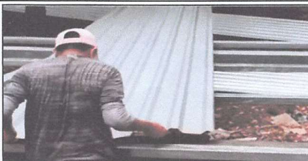
Foto 2: Suministro e instalación de lámina troquelada calibre 26, en el módulo de computación.
