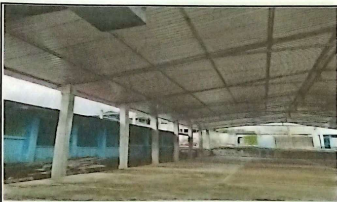
Foto 3: Suministro de cimentación para techo de cancha
