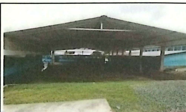
Foto 5: Suministro de lámina troquelada calibre 26
