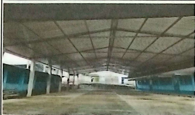
Foto 1: Suministro de cimentación para techo de cancha
