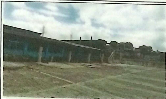
Foto 1: Suministro de cimentación para techo de cancha construcción de columnas de concreto
