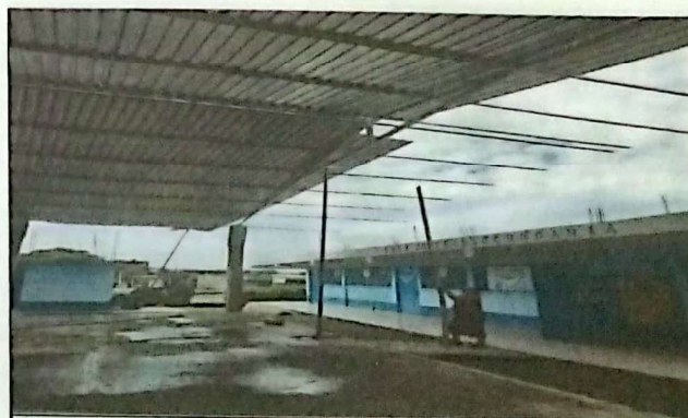
Foto 6: suministro de lámina troquelada calibre 26
