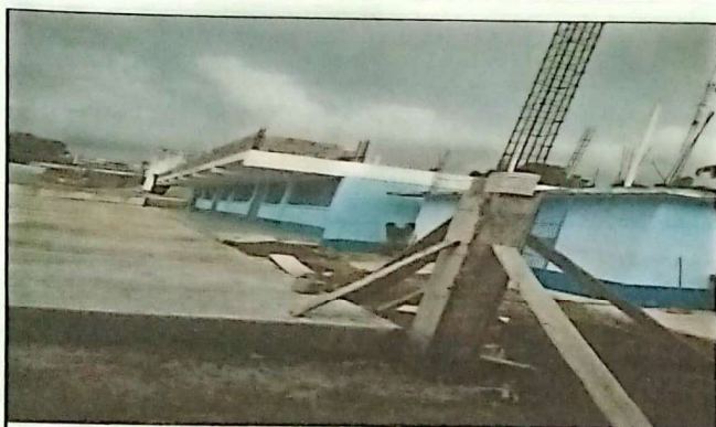
Foto 3: Suministro de estructura metálica de cancha Construcción de columnas de concreto
