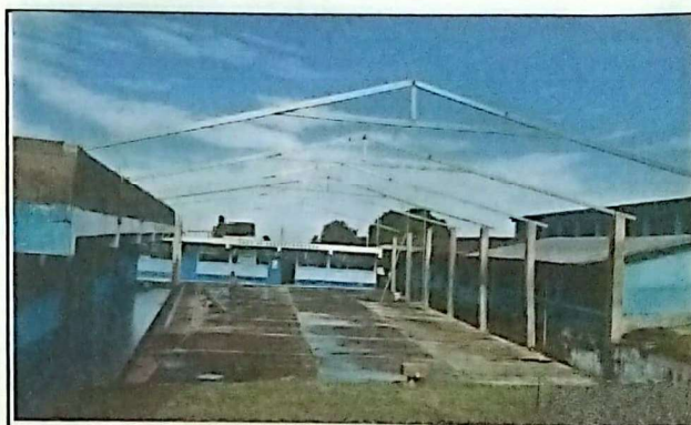
Foto 4: Suministro de estructura metálica de cancha Primera parte de estructura de metal
