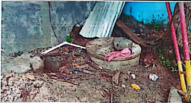
sustitucion de pozo
