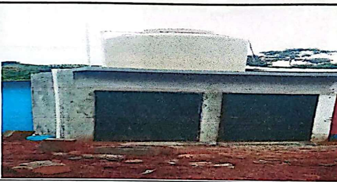
sustitucion de baños
