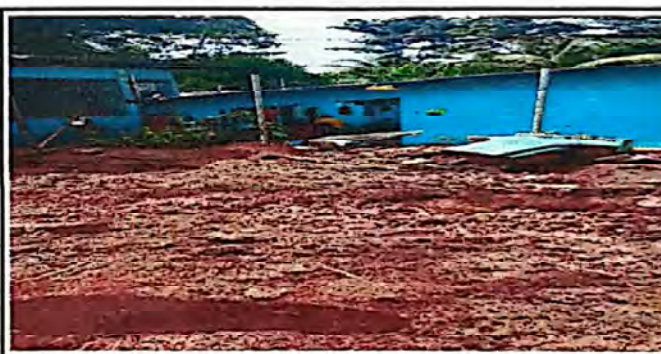
sustitucion de baños
