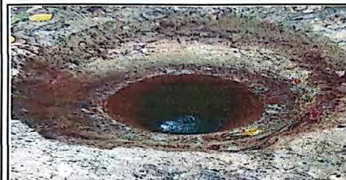
sustitucion de pozo
