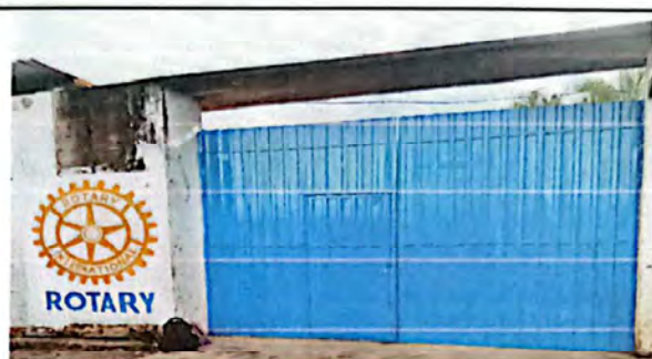
Foto 4: MANTENIMIENTO DE PORTON
