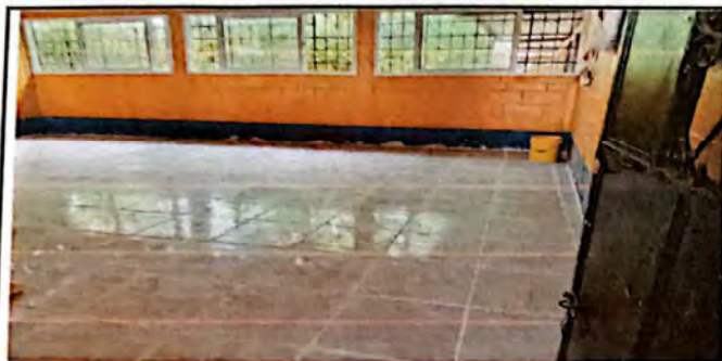
Foto 3: SUMINISTRO DE PISO
