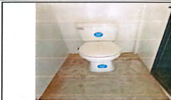
Foto 2: SUMINISTRO DE INODORO
