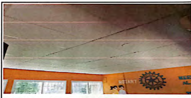
Foto 4: SUMINISTRO DE CIELO FALSO
