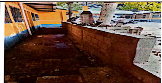
Foto 3: SUTITUCION DE MURO Y CUNETA DE AGUA PLUVIAL
