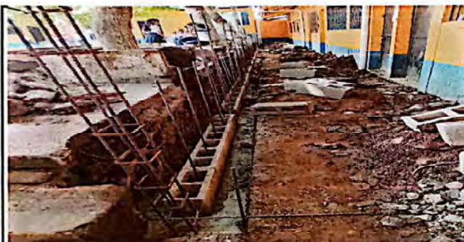
Foto 3: SUTITUCION DE MURO Y CUNETETA DE AGUA PLUVIAL
