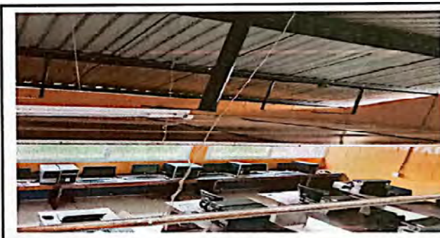
Foto 4: SUSTITUCION DE CIELO FALSO
