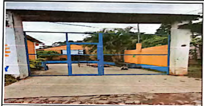
Foto 2: MANTENIMIENTO DE PORTON
