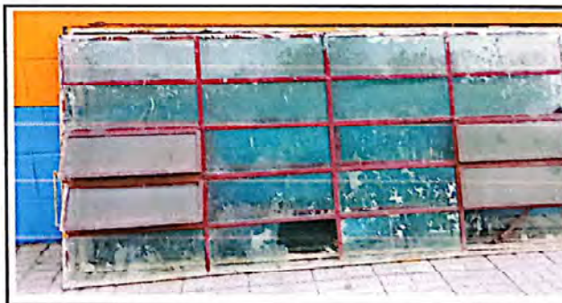
Foto 6: Sustitucion de Balcones
