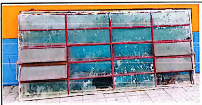
Foto 5: Sustitución de ventanas
