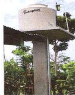
Foto 8: Vista del deposito de Agua de 1,100 litros finalizado al 100%
