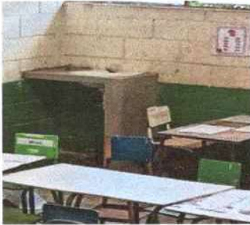
Foto 7: Vista de lavamanos con mesa de concreto finalizado al 100%
