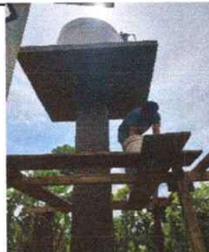
Foto 4: Sustitución de Deposito de Agua
