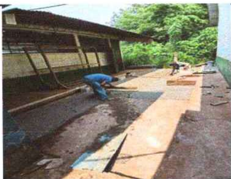
Foto 3: Reparación de Banquetas.
