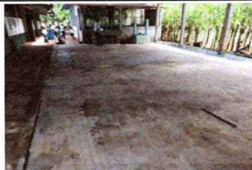
Foto 4: Vista de torta de concreto finalizada al 100%
