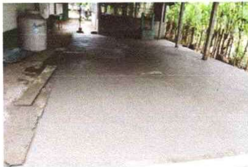
Foto 2: Reparación Torta de concreto de salón de Actos.
