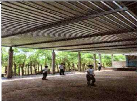
Foto 1: Vista de salón de actos finalizado con estructura de metal y lámina troquelada finalizado al 100%
