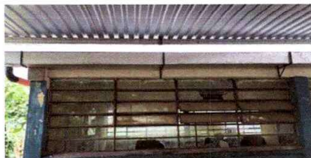
Foto 2: Vista del escenario con estructura de metal y lámina troquelada finalizado al 100%
