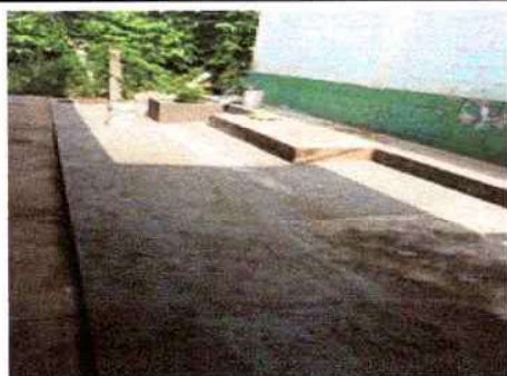
Foto 5: Vista de banquetas de concreto finalizadas al 100%
