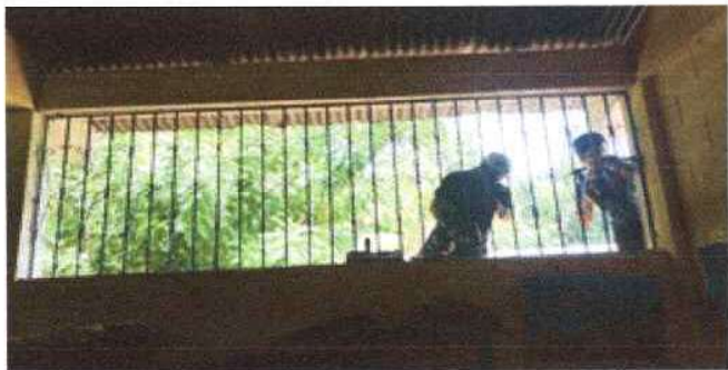
Foto1: Instalación de Balcones
