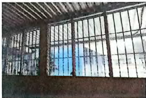
Sustitución de malla por perclana de vidrio
