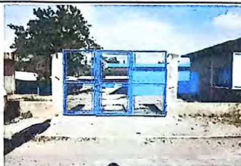
Sustitución de pórtón de metal
