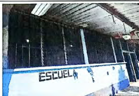
Sustitución de Balcones
