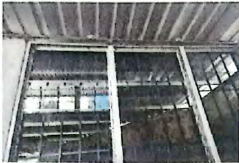
Sustitución de malla por perclana de vidrio
