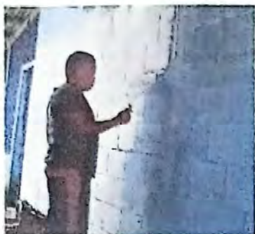
Suministro y aplicación de Impermeabilizante en paredes
