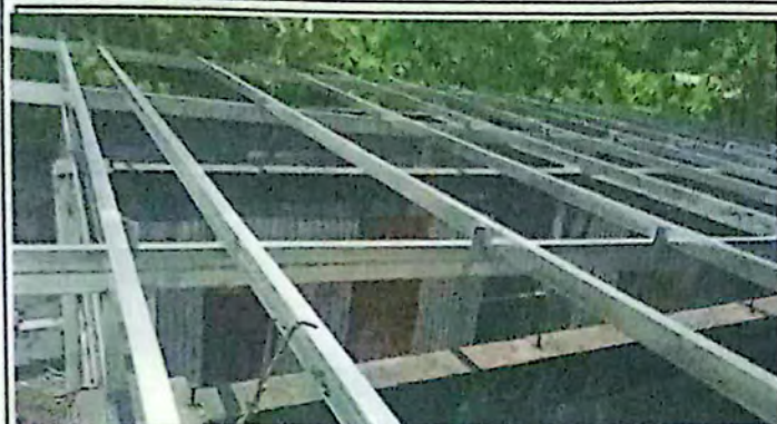
Foto1: suministro e instalacion de estructura metalica
