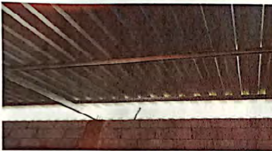
Foto 3: Instalación de Estructura Metálica.
