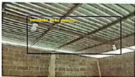
Foto 7: Instalación de luz eléctrica.
