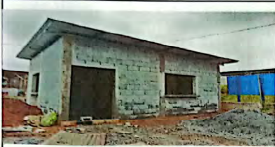
Foto 1: Sustrucción de Muro de Block.
