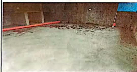
Foto 5: Sustrucción de piso de concreto.
