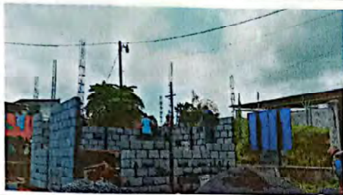
Foto1: Sustitución de muro de block
