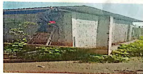
Foto 6: Instalación de drenaje pluvial
