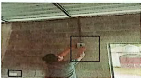
Foto 7: Suministro e instalación de energía eléctrica más fuerza.
