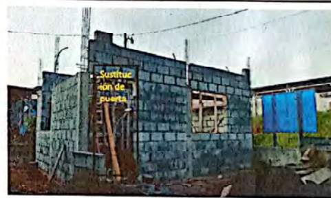
Foto 4: Sustitución de puerta
