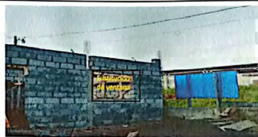
Foto 2: sustitución de ventana.
