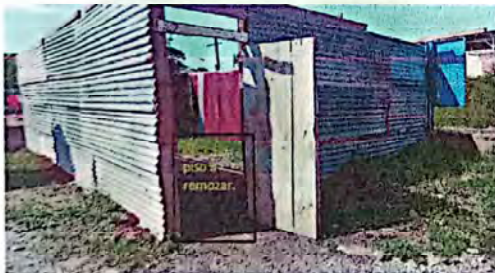
Foto 5: Instalacion de piso de concreto.
