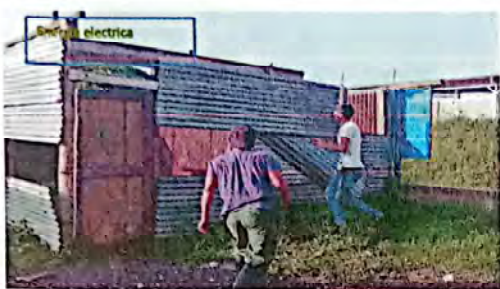
Foto 7: Suministro e instalación de energía eléctrica.
