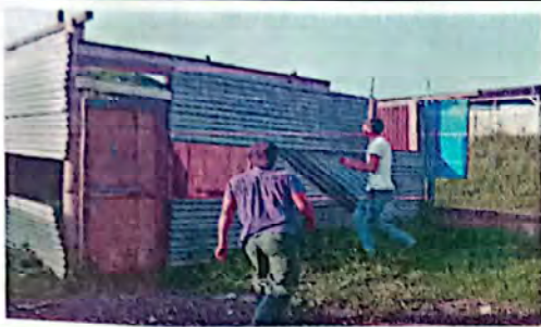
Foto 1: Sustitución de Muro de Block.
