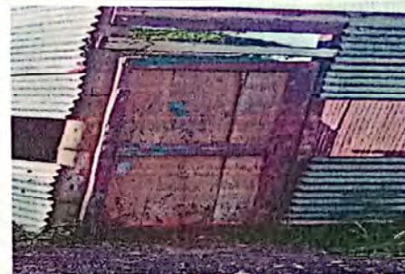
Foto 4: Sustitución de puerta.
