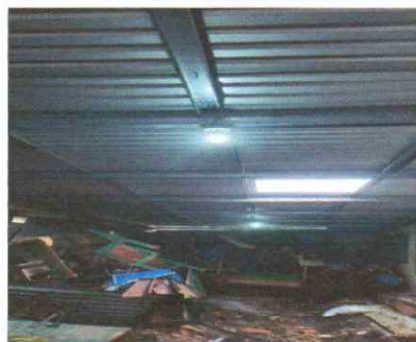
Foto 4: SUMINISTRO E INSTALACIÓN DE LAMINAS TROQUELADAS VISTA INTERIOR
