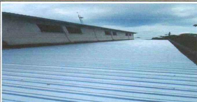
Foto 3: SUMINISTRO E INSTACIÓN DE LÁMINA TROQUELADA VISTA EXTERIOR
