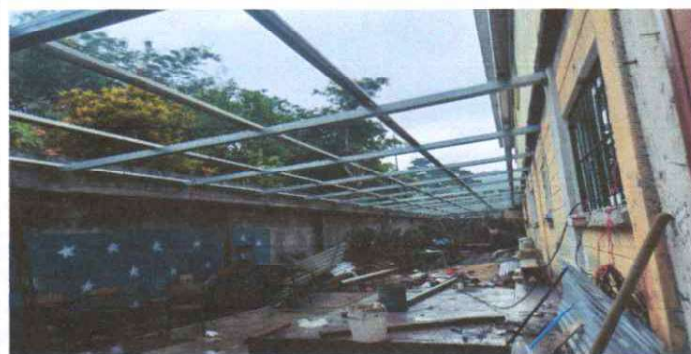
Foto1: INSTALACIÓN DE ESTRUCTURA PORTANTE DE METAL FINALIZADO
