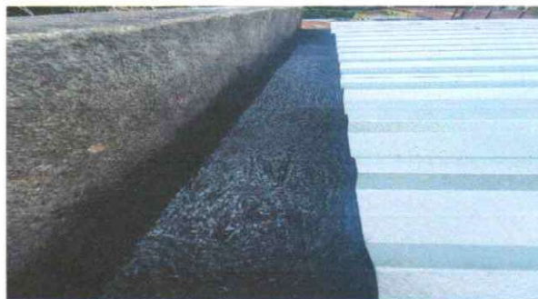
Foto 2: REPARACIÓN DE CANAL DE CONCRETO FINALIZADO
