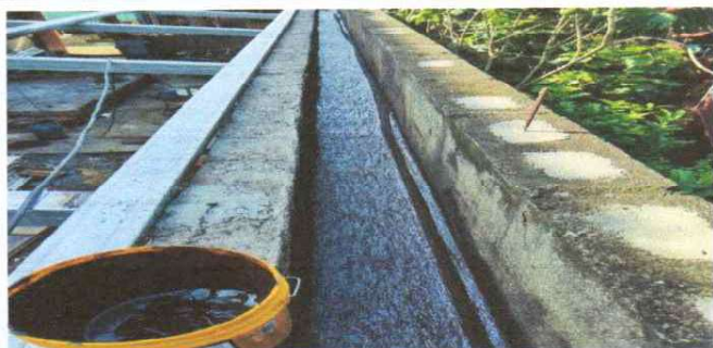
Foto 3: APLICACIÓN DE HIPERMEABILIZANTE
