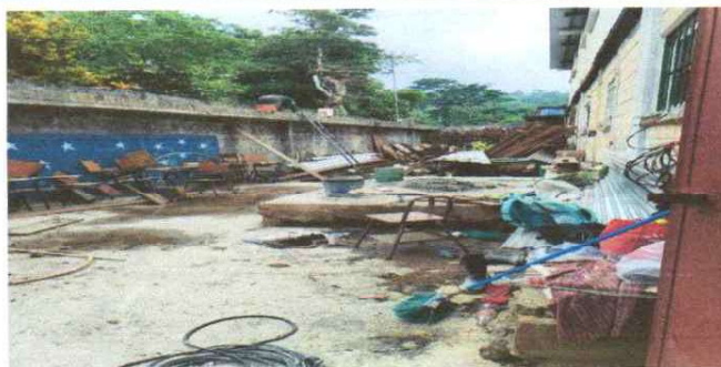
Foto 4: DESARME DE LÁMINAS Y VIGAS
