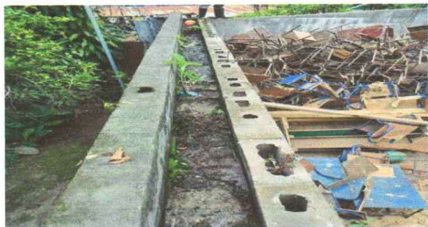
Foto1: LIMPIEZA DE CANAL
