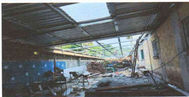
Foto 6: SUMINISTRO E INSTALACIÓN DE LÁMINA TROQUELADA CALIBRE 26
