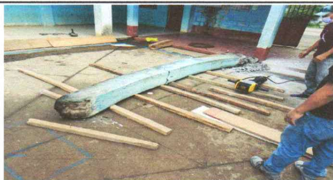
Foto 9: DEMOLICIÓN DE COLUMNAS DE CANASTAS
