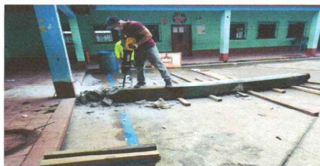
Foto 10: DEMOLICIÓN DE COLUMNAS DE CANASTAS
