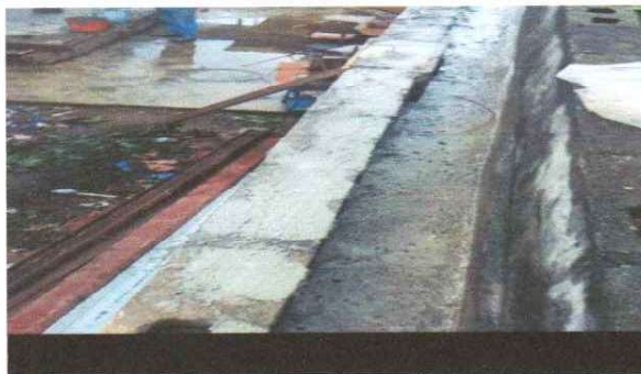
Foto 2: LIMPIEZA DE CANAL
