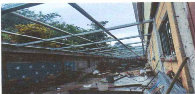
Foto 5: SUMINISTRO E INSTALACIÓN DE SOPORTE DE METAL
