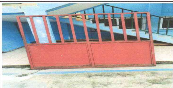
FOTO 11: DESINSTALACIÓN DE PORTÓN
