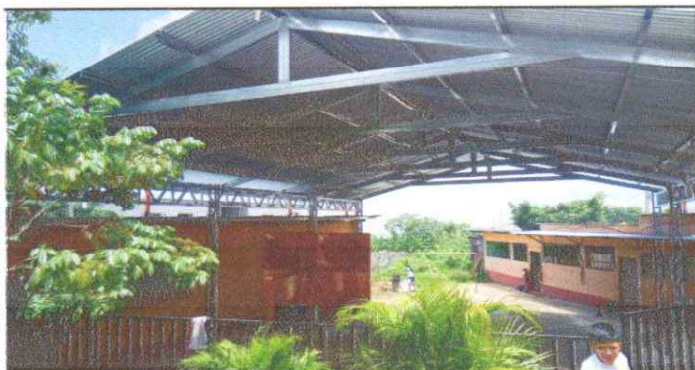
Suministro e instalacion de estructura metalica y lamina calibre 26 en patio
