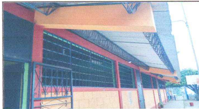
Suministro e instalacion de estructura metalica y lamina calibre 26 en patio
