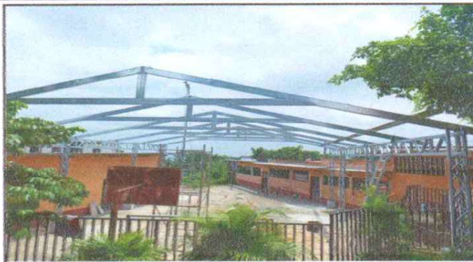
Suministro e instalación de estructura metálica en patio, 15/07/2024
