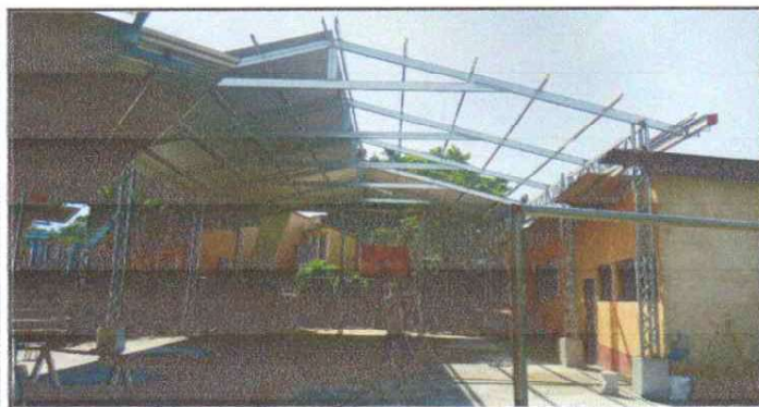
Suministro e instalación de cubierta de lámina calibre 26, 22/07/2024
