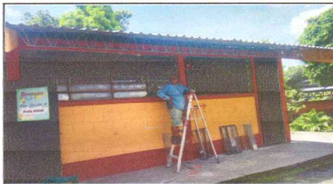
Suministro e instalación de balcones, 15/08/2024
