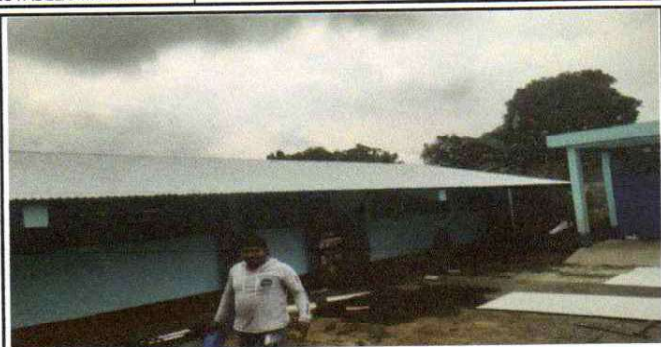
Foto1: VISTA FACHADA INTERIOR LAMINA COLOCADA AL 100%
