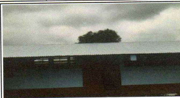
Foto 2: VISTA DE INSTALACIÓN DE LÁMINA FINALIZADO
