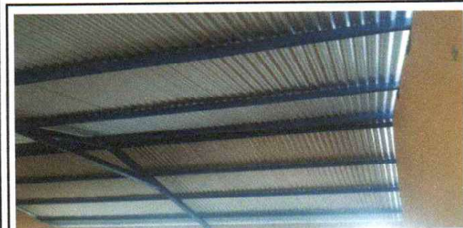
Foto 5: INTERIOR DELAS AULAS CON SUMINISTRO E INSTALACIÓN DE LAMINAS FINALIZADO
