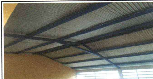
Foto 6: INTERIOR DELAS AULAS CON SUMINISTRO E INSTALACIÓN DE LAMINAS FINALIZADO
