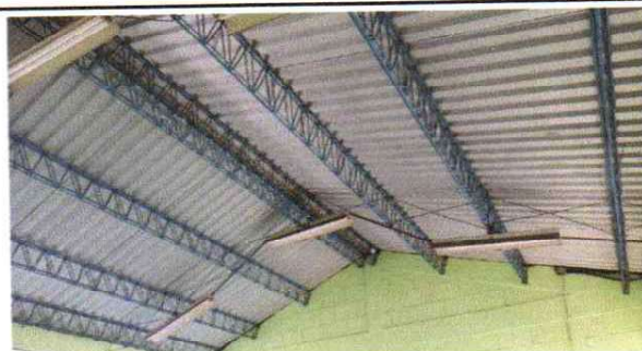
Foto 6: FINALIZA LA COLOCACIÓN DE LÁMINAS
