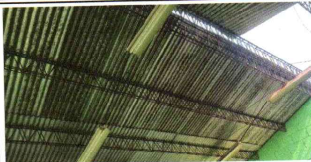
Foto 2: SUMINISTRO E INSTALACIÓN DE LÁMINA PRIMERA FASE
