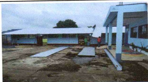
Foto 5: SUMINISTRO E INSTALACIÓN DE LÁMINAS
