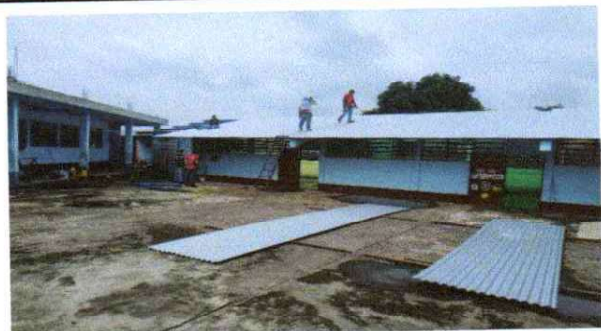
Foto 3: SUMINISTRO E INSTALACIÓN DE CAPOTES EN TECHO
