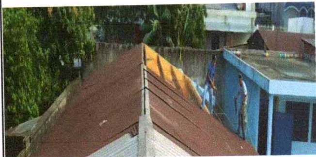
Foto1: RETIRO DE LÁMINAS ANTIGUAS
