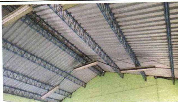
Foto 4: MANTENIMIENTO DE PINTURA EN ESTRUCTURA METALICA EXISTENTE
