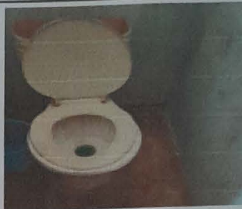
Sustitución de inodoros elongados
