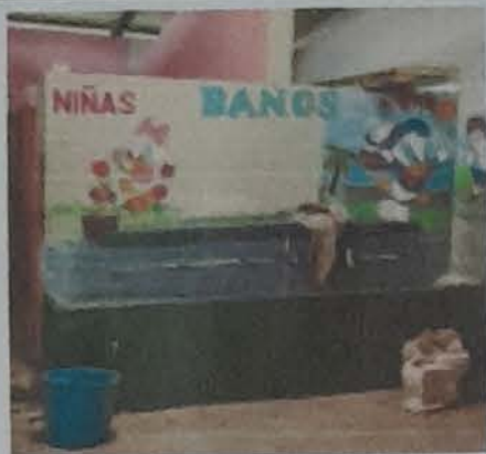
Mantenimiento de sistema de agua potable, Suministro e instalación de drenaje de aguas negras
