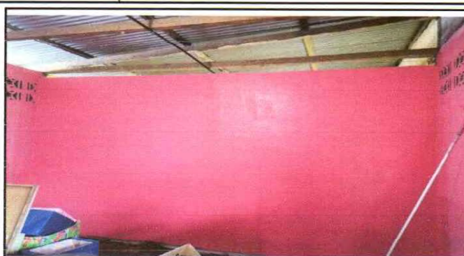
Suminsitro e instalación de muro de block de divisiones intermedias
