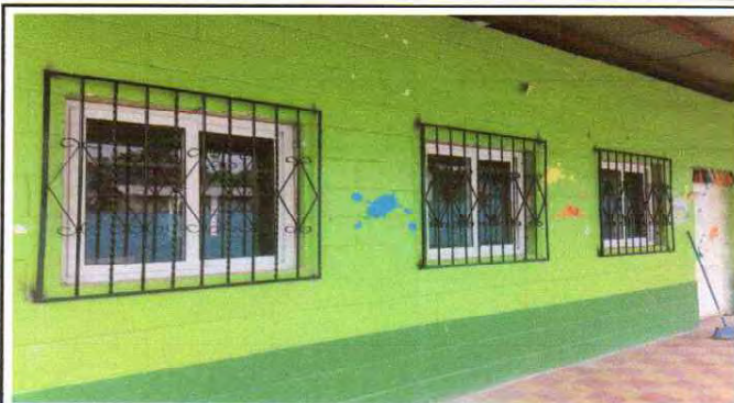
Suministro e instalación de balcones de metal.
