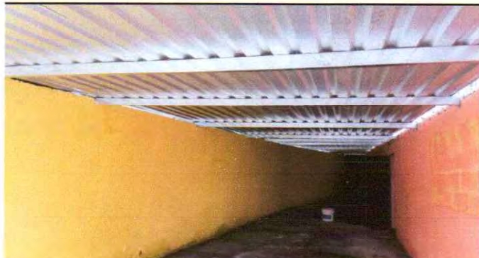
Sustitución de estructura metálica e instalación de lámina troquelada calibre 26 para área infantil.
