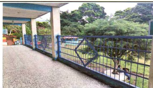
Mantenimiento de Baranda Metálica (lijado, cepillado y aplicación de pintura anricorrosiva)
