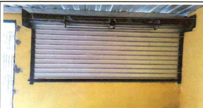
Suministro e instalación de cortina metálica
