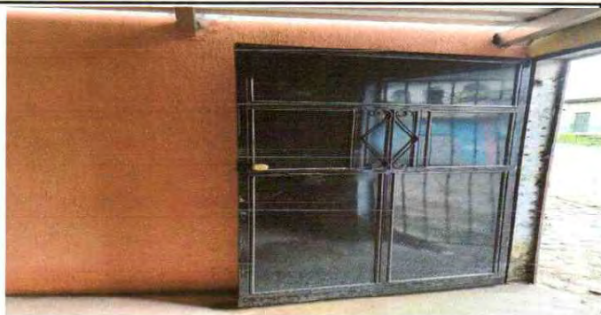
Sumistro e instalación de puerta de metal.
