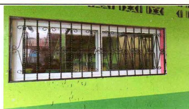
Mantenimiento de balcones de metal (lijado, cepillado y aplicación de pintura anticorrosiva)
