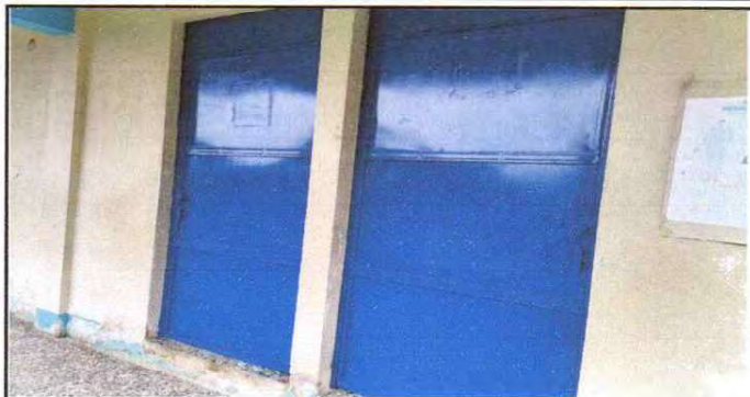
Mantenimiento de puertas de metal ( lijado, cepillado y aplicación de pintura anticorrosiva)
