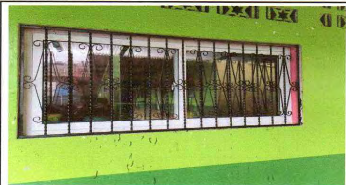
Suministro e instalación de ventanas de PVC
