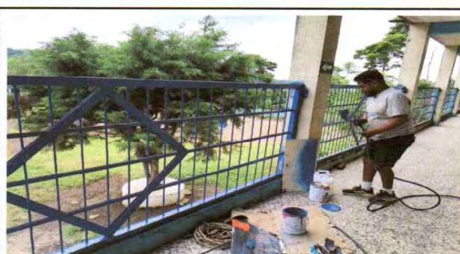
Mantenimiento de baranda metálica (lijado, cepillado y aplicación de pintura anticorrosiva)
