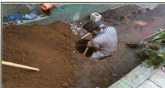
Sumiistro e instalación de sifón para drenaje.
