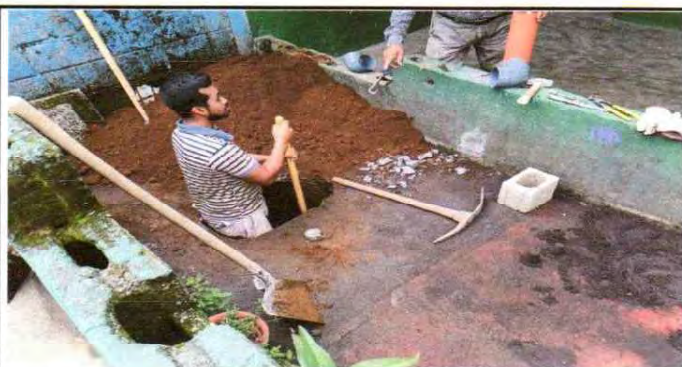
Sumiistro e instalación de sifón para drenaje.
