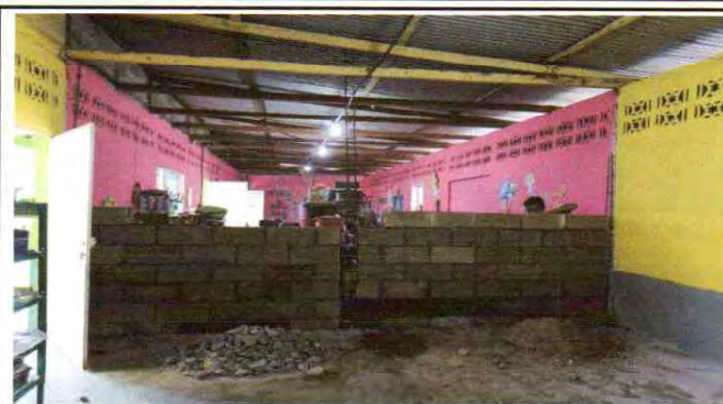
Suministro e instalación de muro de block de divisiones intermedias
