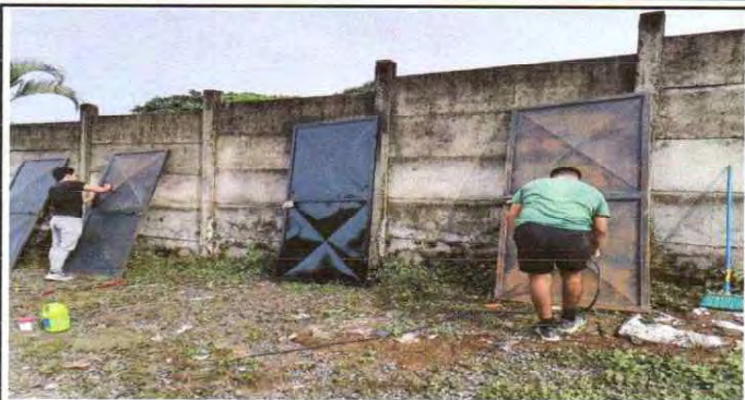
Mantenimiento de puertas de metal ( lijado, cepillado y aplicación de pintura anticorrosiva)
