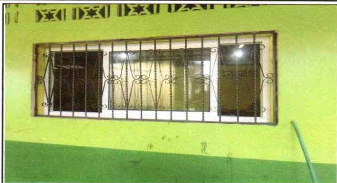
Suministro e instalación de ventanas de PVC
