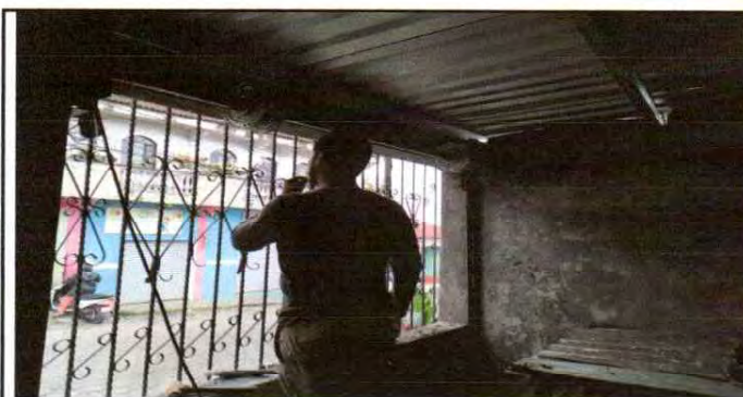
Suministro e instalación de cortina metálica
