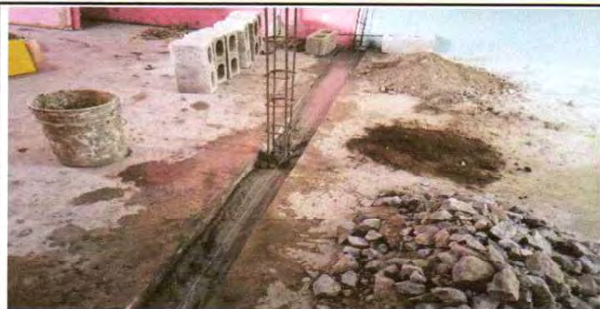
Suministro e instalación de muro de block de divisiones intermedias
