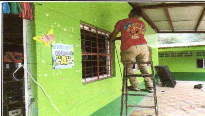
Suministro e instalación de balcones de metalicos
