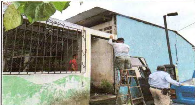
Suministro e instalación de puertas de metal
