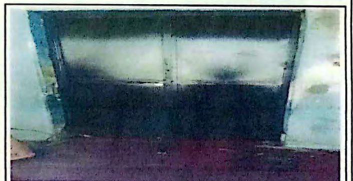
Foto 6: Suministro de puerta de metal de 1.30 de ancho por 2.20 de alto, doble hoja y aplicacion de pintura anticorrosiva.
