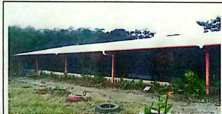
Foto 5: Sustitucion de lamina por lamina troquelada calibre 26 para aulas
