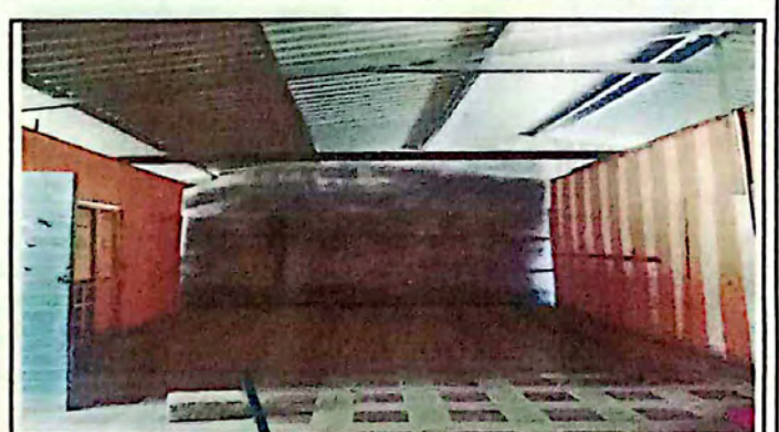
Foto 4: Sustitución de Estructura de soporte actual en mal estado (madera, metal) por metal (costaneras de 4x2 calibre 16 para aulas)
