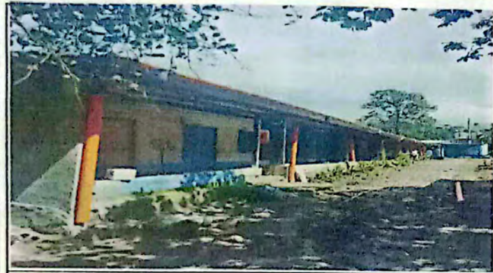
Foto 3: Suministro e Instalacion de tubos pvc de 3 para canales y bajadas de agua pluvial
