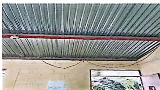
Sustitución de plafoneras, ducto, cableado, focos.
