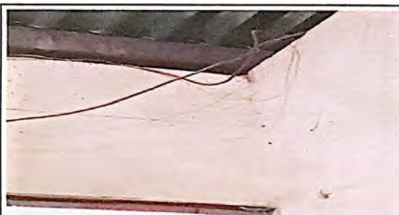
Sustitución de toma corrientes, ductos y cableado eléctrico N.- 10 y 12.
