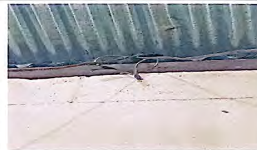
Sustitución de plafoneras, ducto, cableado, focos.
