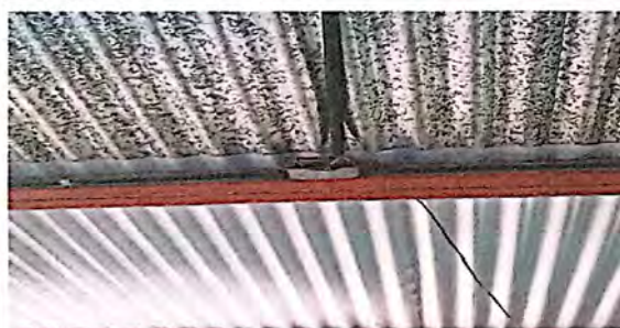
Sustitución de plafoneras, ducto, cableado, focos.
