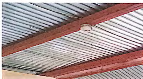
Sustitución de plafoneras, ducto, cableado, focos.
