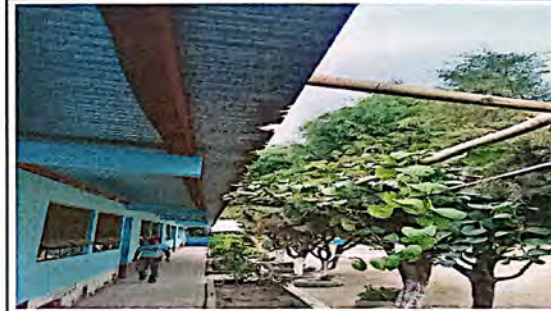
Suministro de lámina acanalada calibre 24, vigas metálicas, corredor del modulo de aulas.
