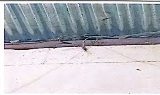
Sustitución de toma corrientes, ductos y cableado eléctrico N.- 10 y 12.
