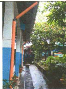
Foto 4: SUMINISTRO E INSTALACIÓN DE BAJADAS DE AGUA FINALIZADO
