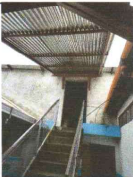
Foto 3: SUMINISTRO E INSTALACIÓN DE TECHO A GRADAS DE BODEGA
