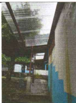
Foto 5: SUMINISTRO E INSTALACIÓN DE TECHO A GRADAS DE INGRESO
