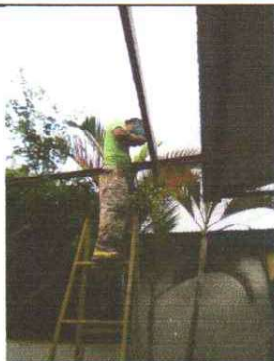
Foto1: SUMINISTRO E INSTALACIÓN DE TECHO EN INGRESO PRINCIPAL
