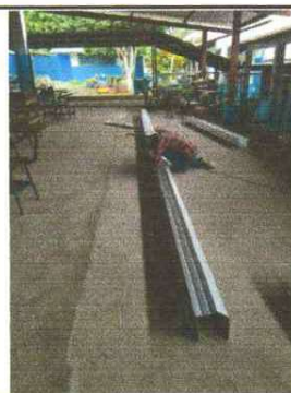
Foto 4: SUMINISTRO E INSTALACIÓN DE BAJADAS DE AGUA
