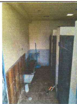
Foto 2: MANTENIMIENTO DE SANITARIOS
