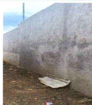
Foto 6: VISTA EXTERIOR DE MURO REALIZADO AL 100%
