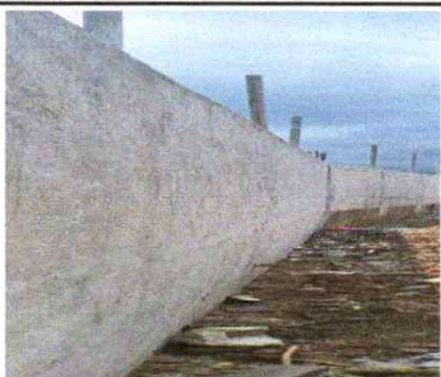
Foto 5: VISTA EXTERIOR DE MURO FINALIZADO AL 100%
