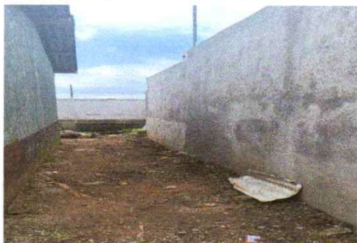
Foto 1: VISTA FACHADA INTERIOR DEL MURO PERIMETAL AL 100%
