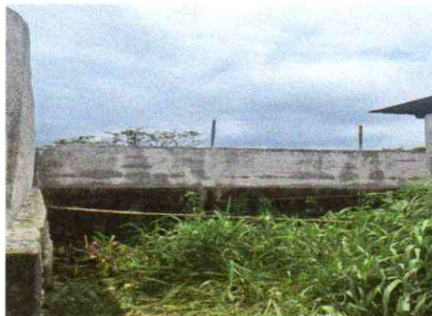
Foto 3: VISTA INTERIOR EN SEGUIMIENTO EN CONSTRUCCIÓN DE MURO AL 100%
