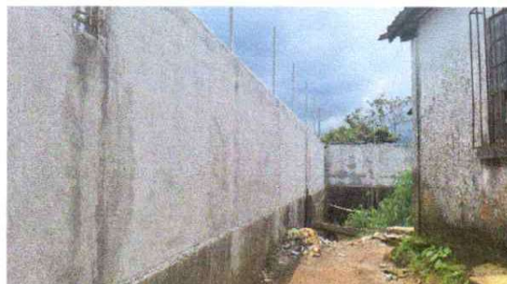
Foto 2: VISTA DE FINALIZACIÓN DE SEGUIMIENTO DE MURO PERIMETRAL AL 100%
