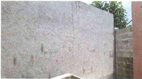
Foto 3: VISTA EN SEGUIMIENTO DE LEVANTADO DE MURO PERIMETRAL AL 100%
