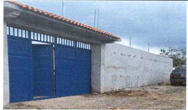
Foto 4: VISTA DE LA PARTE EXTERIOR DE LEVANTADO DE MURO AL 100%
