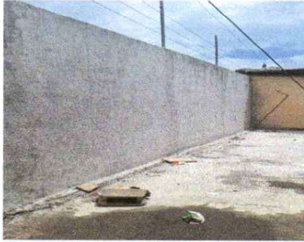
Foto 1: VISTA FACHADA INTERIOR EN LEVANTAMIENTO DE MURO AL 100%
