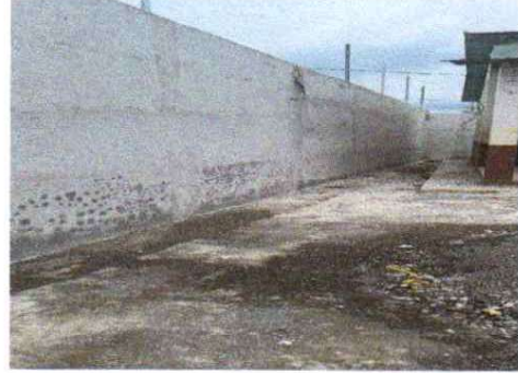
Foto 2: REALIZACIÓN EN SEGUIMIENTO FINALIZADO DE MURO PERIMETRAL AL 100%
