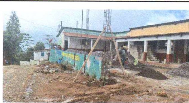
Foto 2: REALIZACIÓN DE SEGUIMIENTO DE MURO PERIMETRAL
