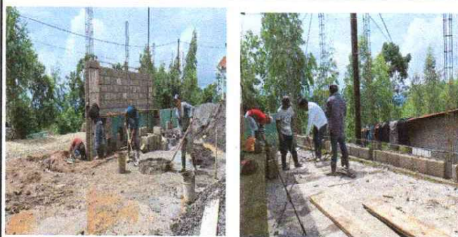
Foto 6: TRABAJO EN SEGUIMIENTO EN LEVANTADO DE MURO PERIMETRAL INTERIOR Y EXTERIOR DEL CENTRO EDUCATIVO.
