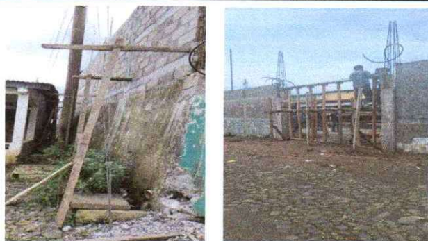
Foto 5: SEGUIMIENTO EN LEVANTADO DE MURO PERIMETRAL Y REALIZACIÓN DEL PORTON DETERIORADO
