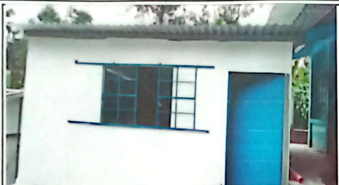
Foto1: Sustrucion de la puerta.
