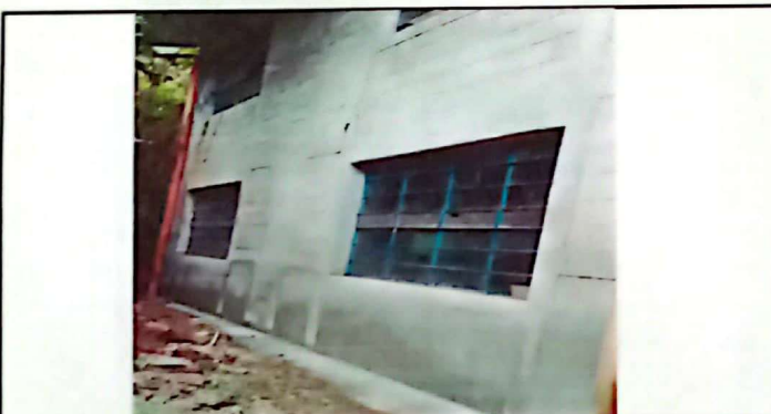
Foto 5: Repello de un aula que ya estaba en construccion.
