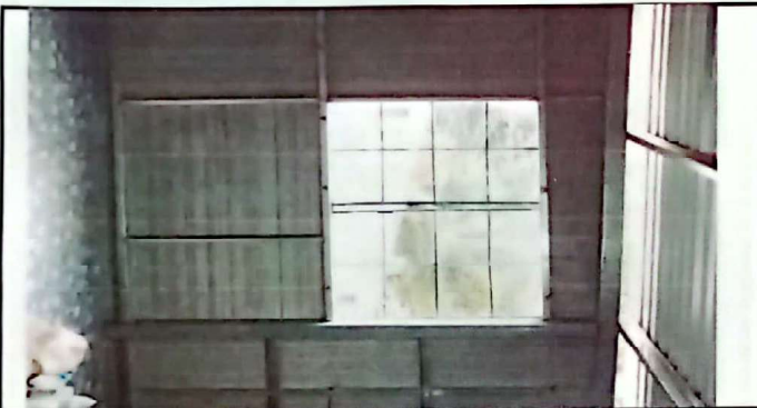
Foto 3: Sustitucion de ventana.
