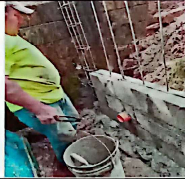
Foto 6: Construccion del muro de contencion.
