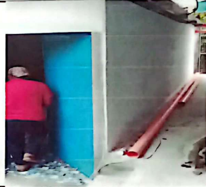
Foto 4: Sustitucion de puerta.
