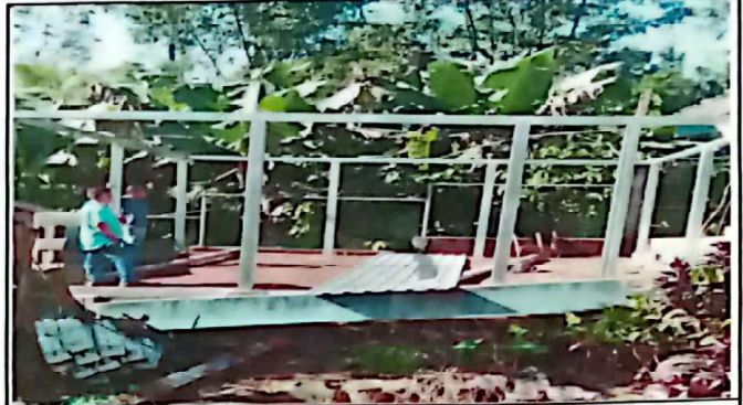
Foto 2: Sustitucion de estructura de techo.
