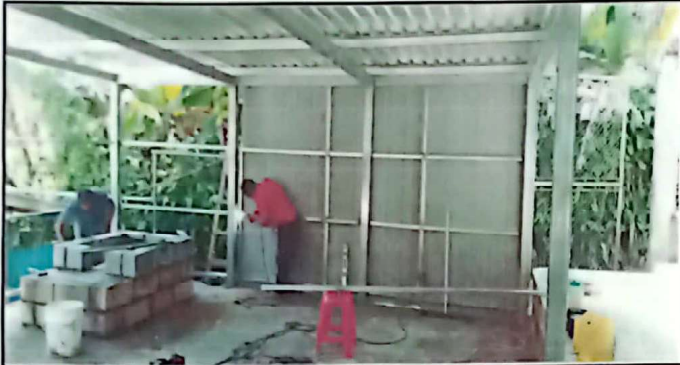
Foto1: Sustitucion del cerramiento por muro Prefabricado con estructura metalica.
